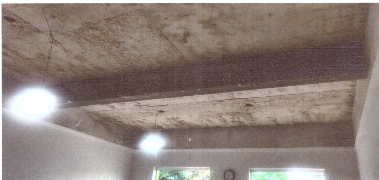
Foto 03: sala 02 – para instalação de gesso rebaixado
