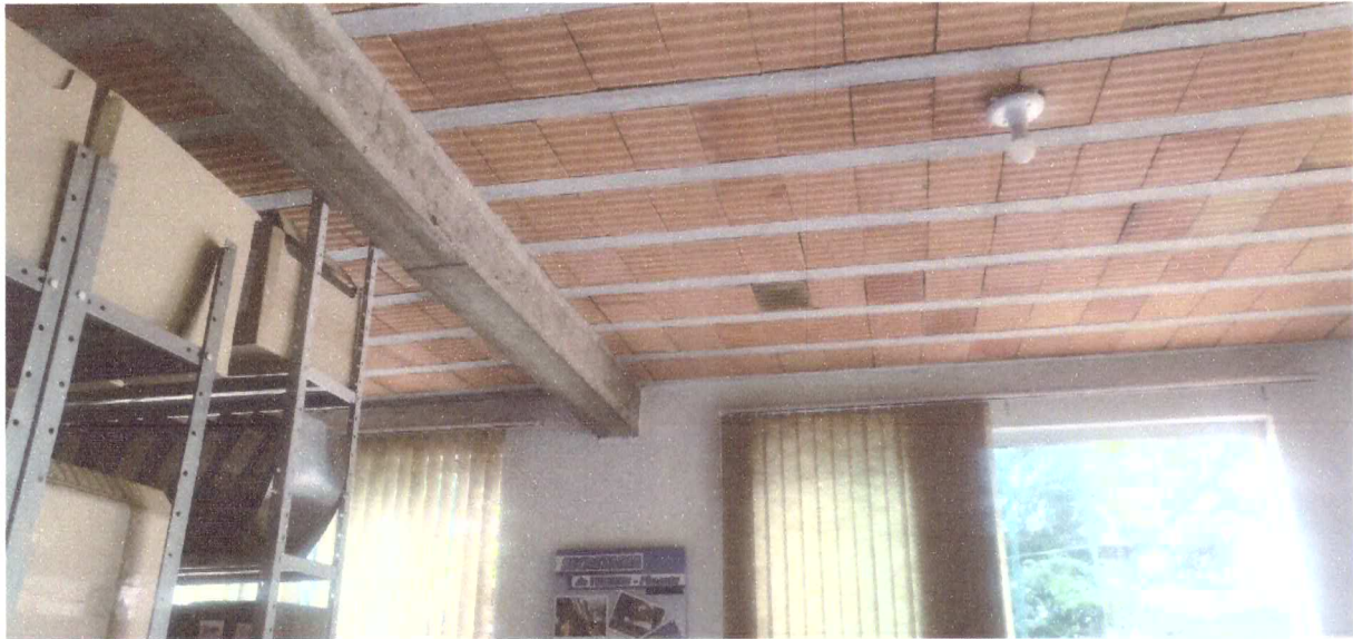
Foto 06: sala 04 – para instalação de gesso rebaixado
