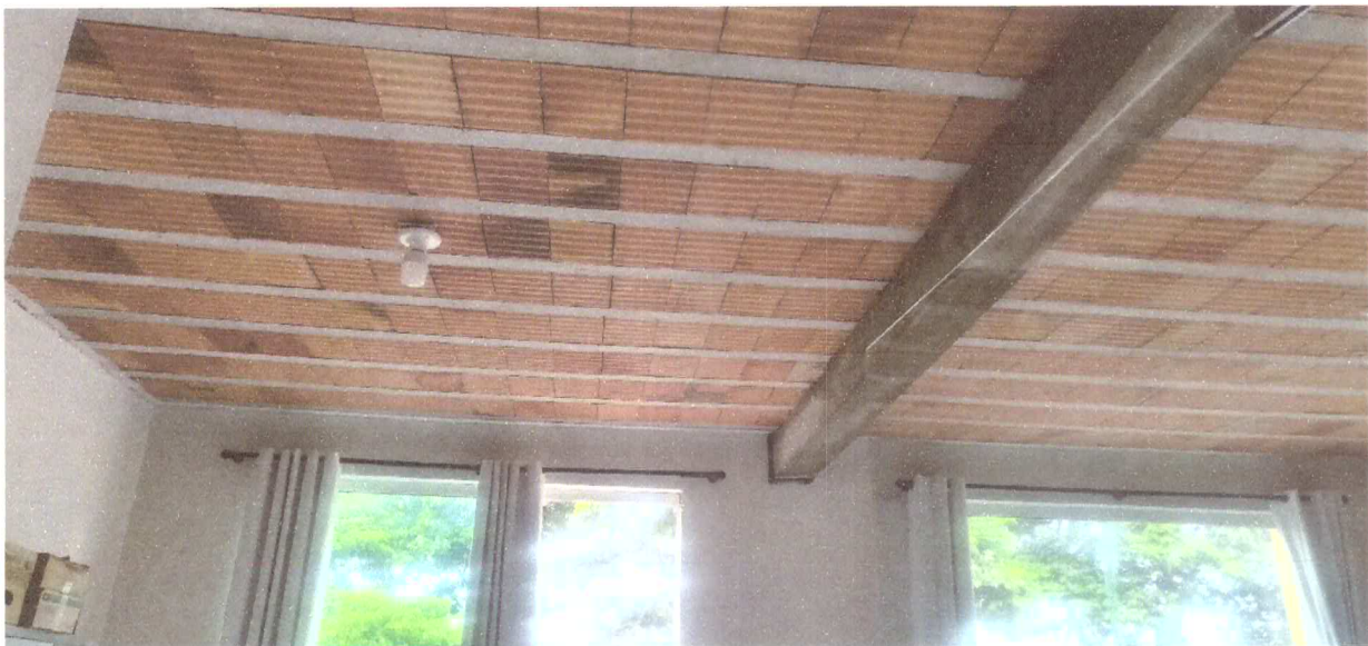
Foto 07: sala 05 – para instalação de gesso rebaixado
