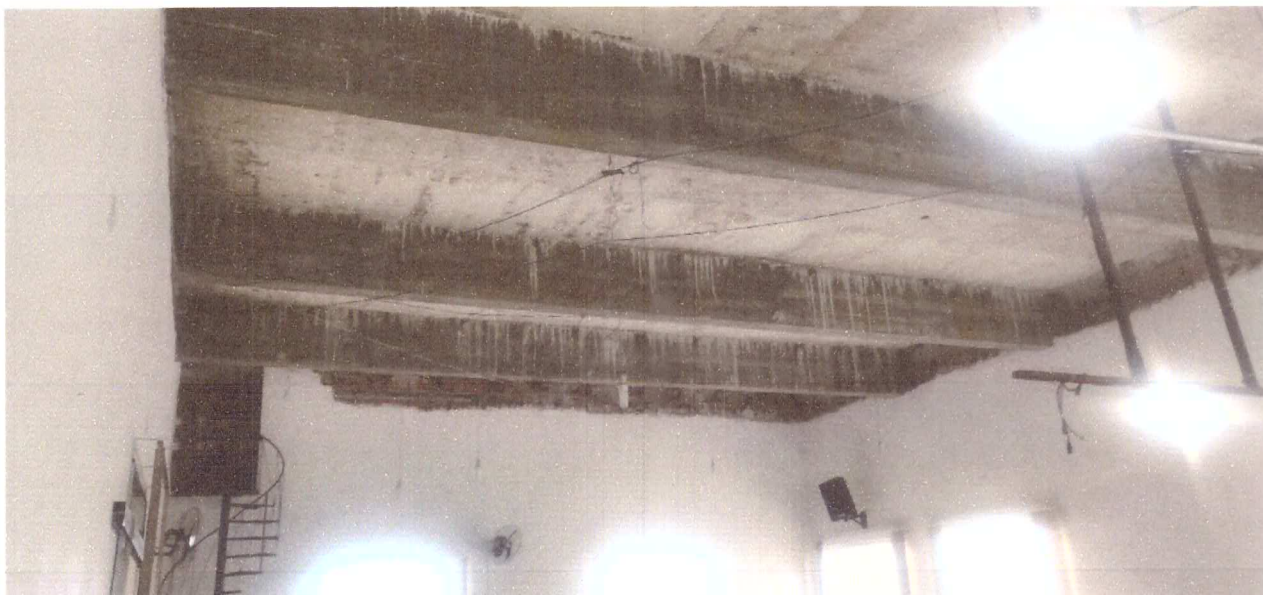
Foto 01: Auditório – para instalação de gesso rebaixado
