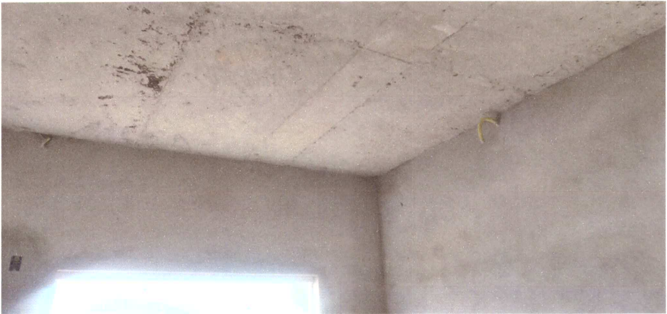
Foto 02: sala 01 – para instalação de gesso rebaxado
