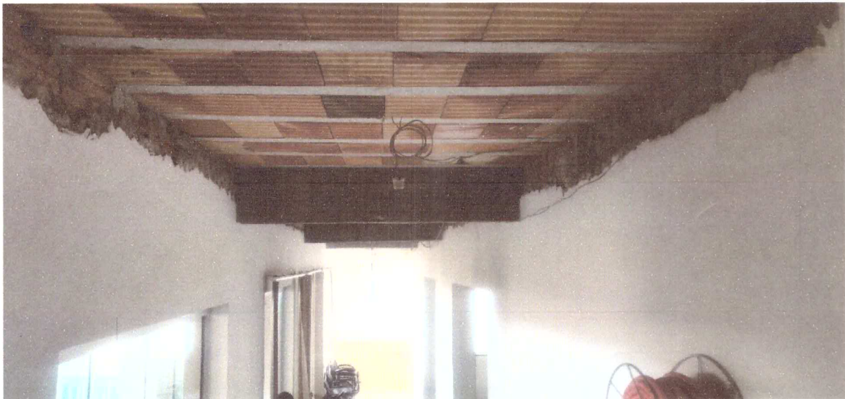
Foto 05: Corredor – para instalação de gesso rebaixado
