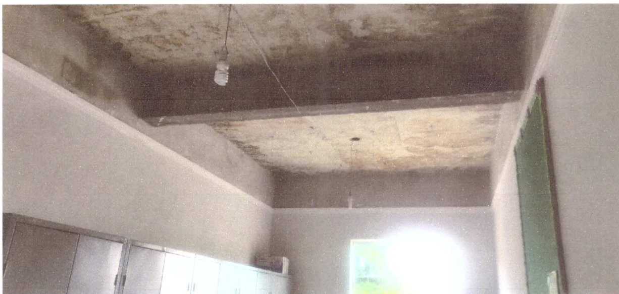
Foto 02: sala 01 – para instalação de gesso rebaixado
