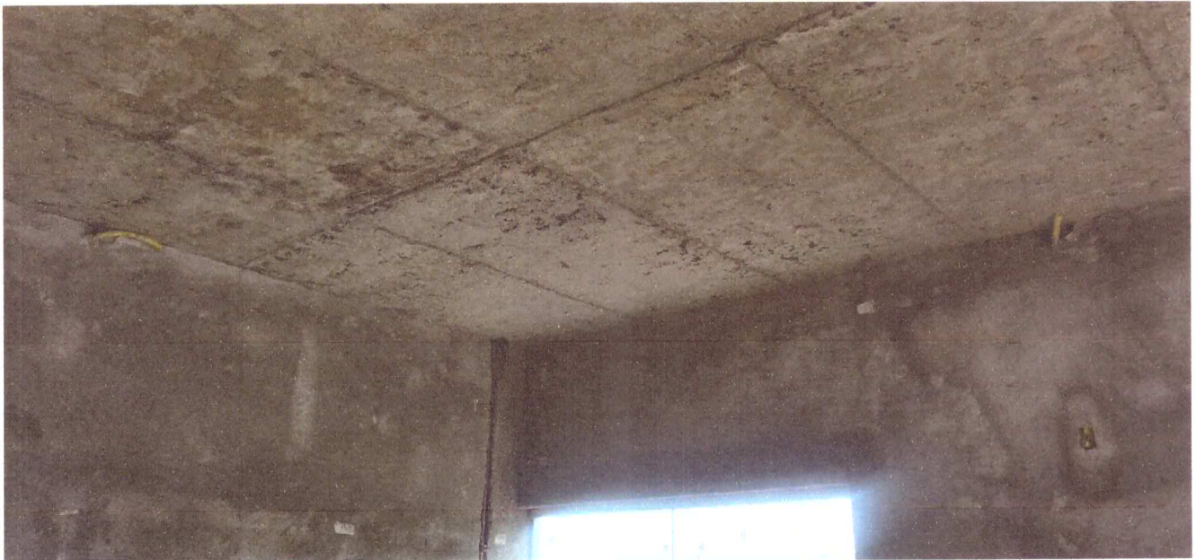
Foto 01: sala 01 – para instalação de gesso rebaixado
