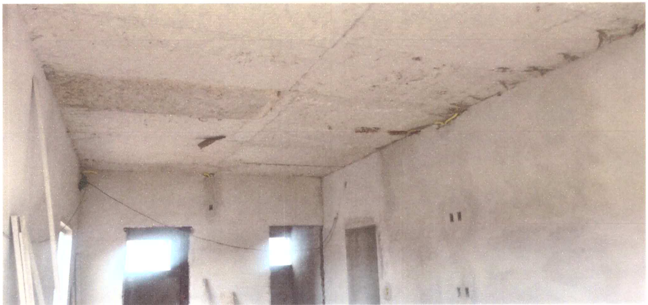
Foto 03: Recepção – para instalação de gesso rebaxado
