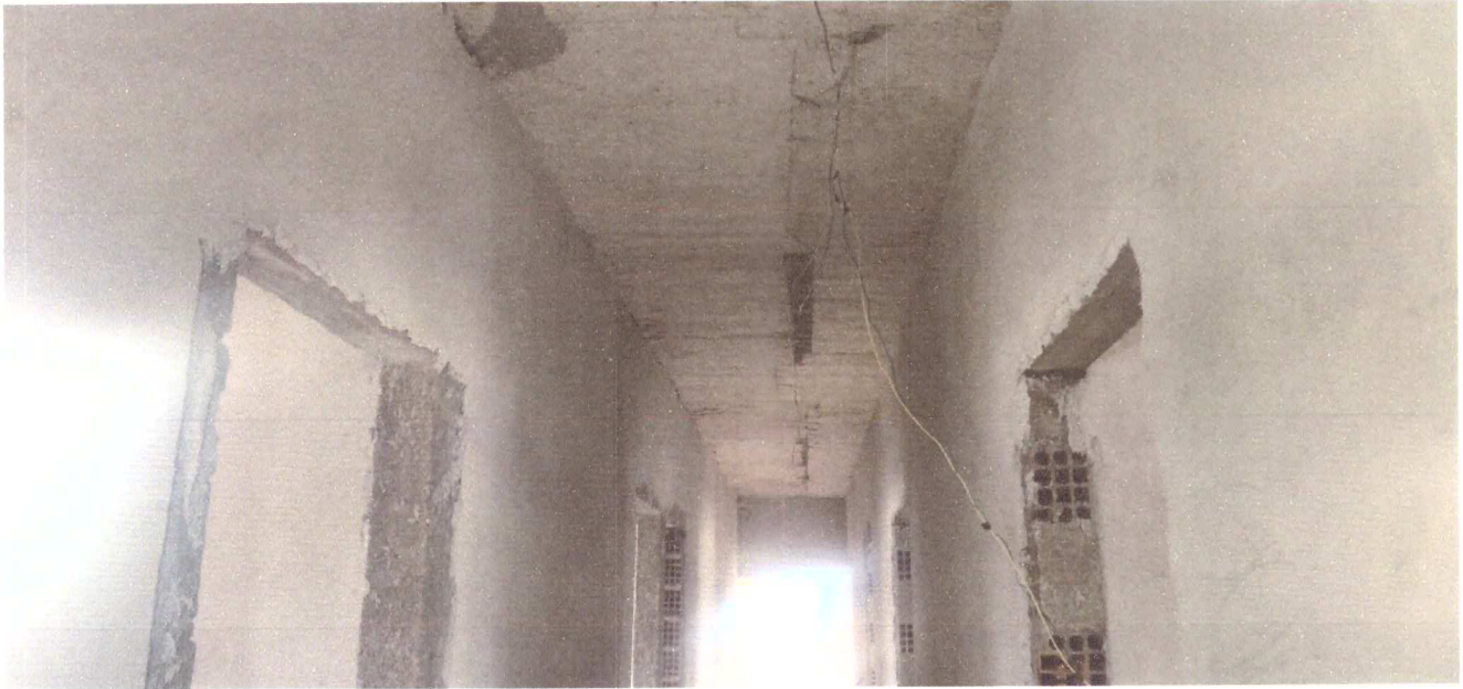
Foto 04: corredor – para instalação de gesso rebaixado
