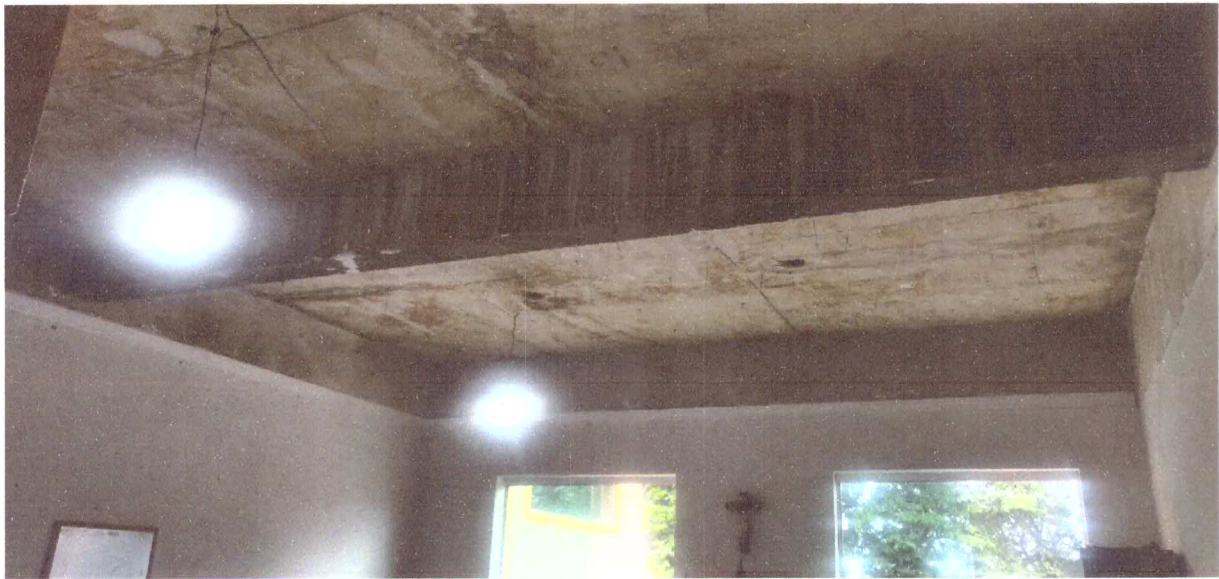
Foto 04: sala 03 – para instalação de gesso rebaixado
